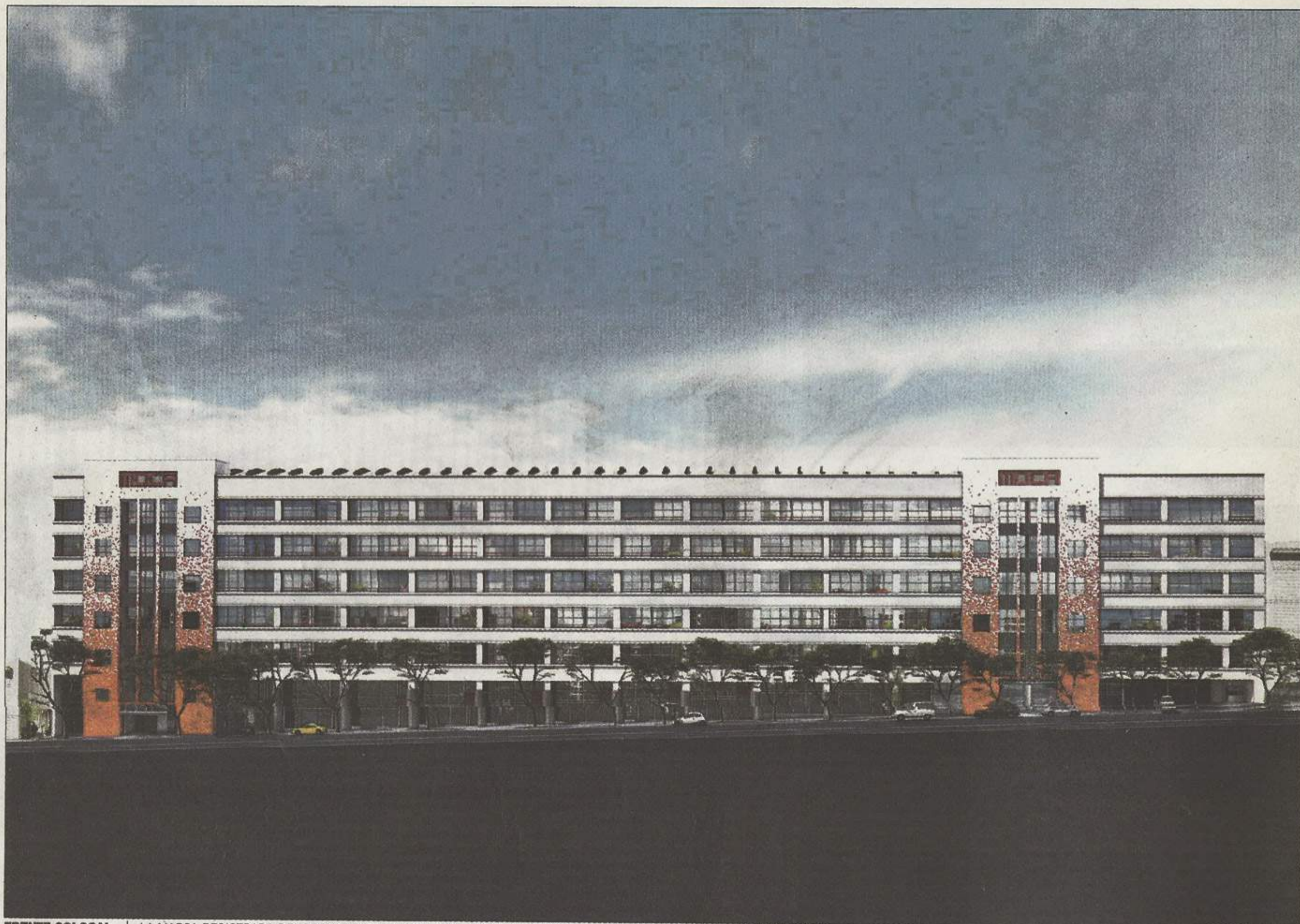
FRENTE COLOSAL | LA MARCA REGISTRADA DEL PROYECTO ES LA FACHADA DE 140 METROS DE LARGO RECICLADA DE LA ANTIGUA FABRICA.
